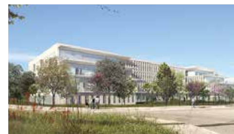
À Aix-en-Provence Immeuble de bureaux Blanc Azur
